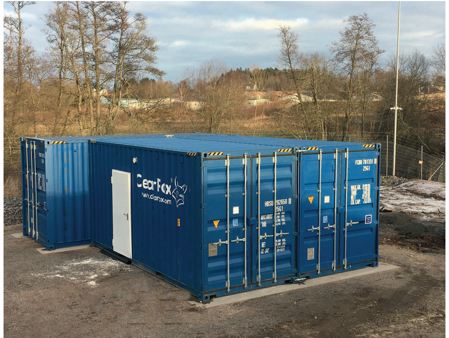
Containerkläranlage mit Druckentspannungsflotation und elektrischer Oxidation für ein Recyclingunternehmen in Schweden © PPU Umwelttechnik
